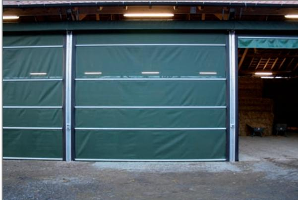
Rolltor mit Stabilisierungsprofilen, Außenansicht
