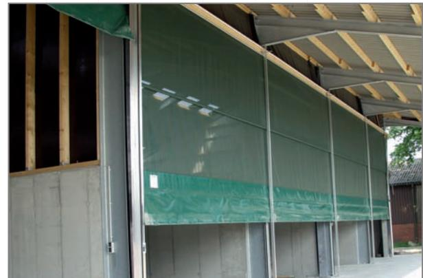
Rollofront mit beweglichem Antrieb an Maschinenhalle
